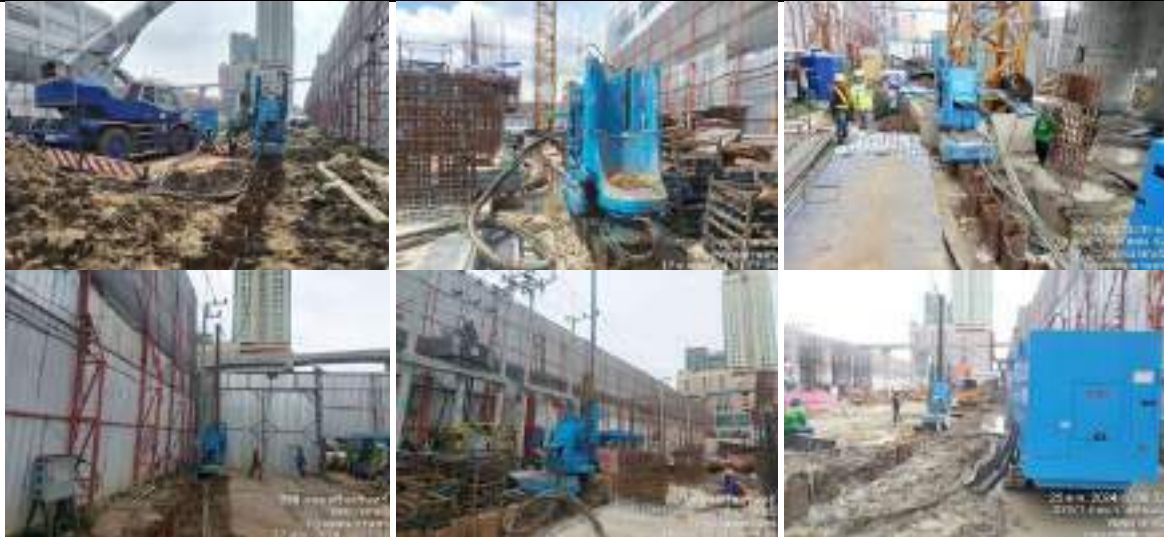
รูปที่ ผ7.49 ระบบ Silent piler
